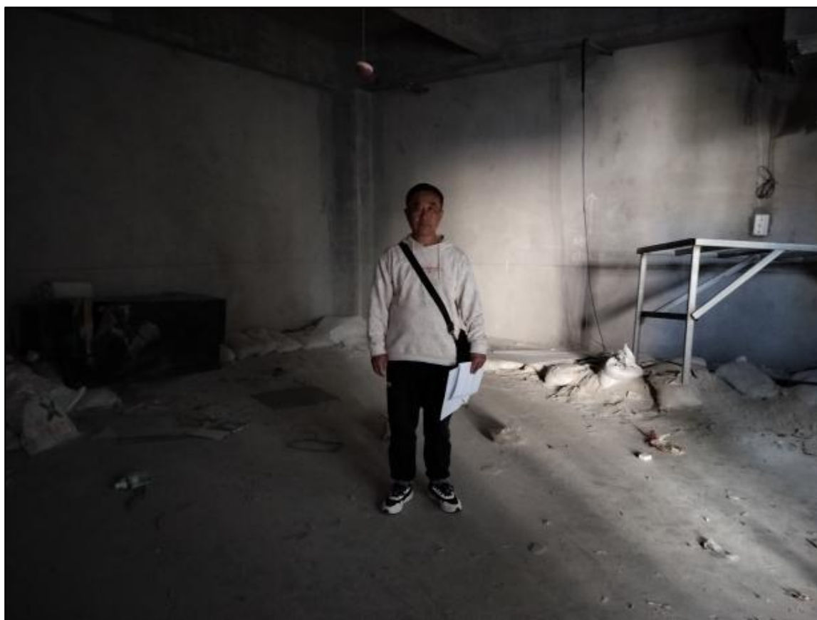
图 1-2 DSA 机房现状图
